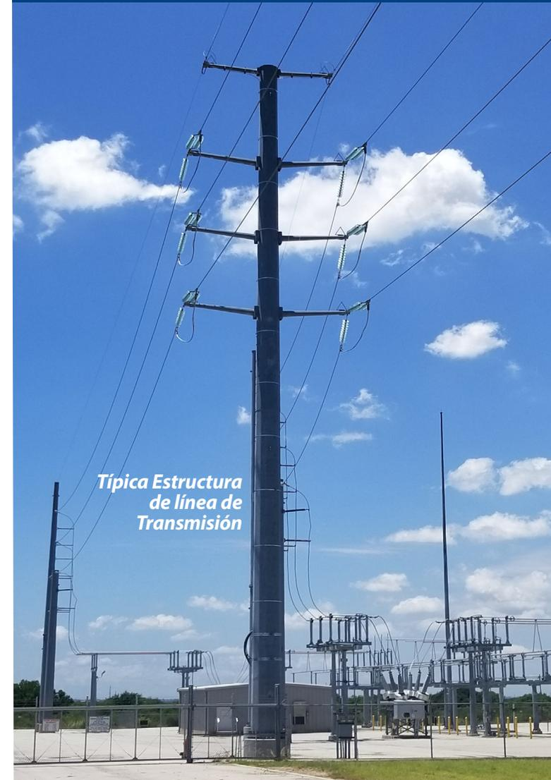
Típica Estructura de línea de Transmisión
